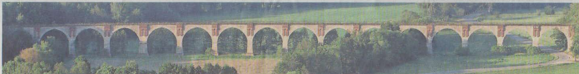
Unter anderem über den Frohnsdorfer Viadukt soll einmal der Radweg führen.
